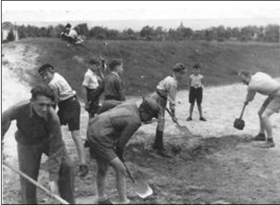
Fot. 11. Harcerze z Podolan przy budowie Domu Harcerza na Winiarach.
